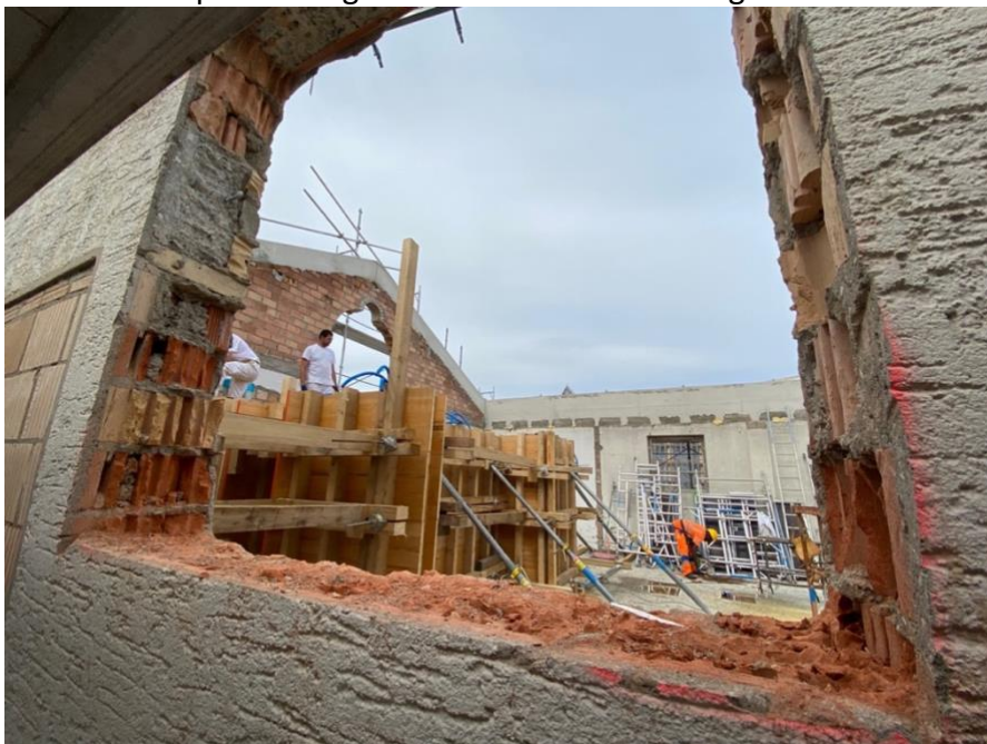
Foto: Fallbeispiel «Wangenstrasse 66»: Umnutzung ohne bauliche Massnahmen (?)
